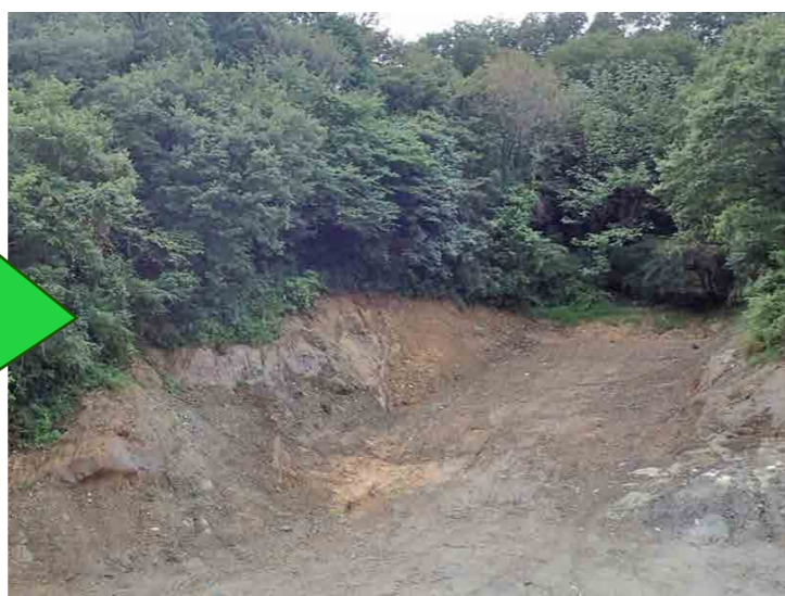
掘削土の搬出後の堆積場（現在）
